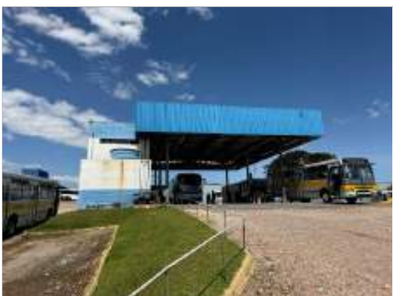
Foto 21 - Vista do Bloco 5 – Pós-lavagem
