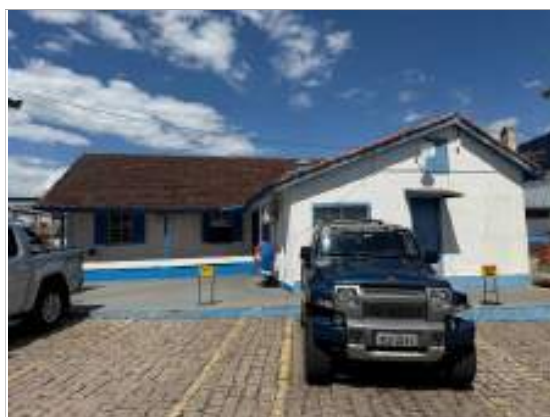
Foto 10 - Vista do Bloco 3 - Administrativo
