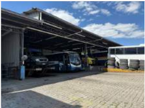
Foto 16 - Vista do Bloco 4 - Manutenção
