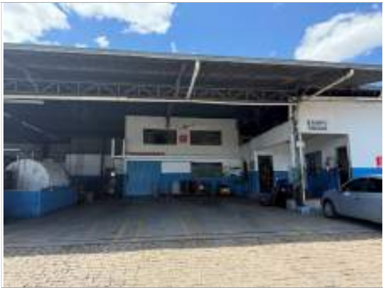
Foto 13 - Vista do Bloco 4 - Manutenção
