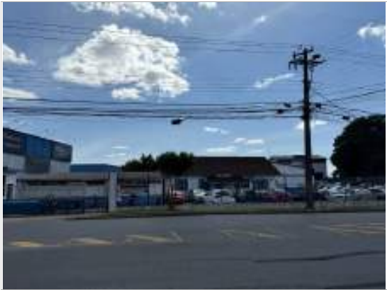
Foto 4 - Fachada do imóvel
