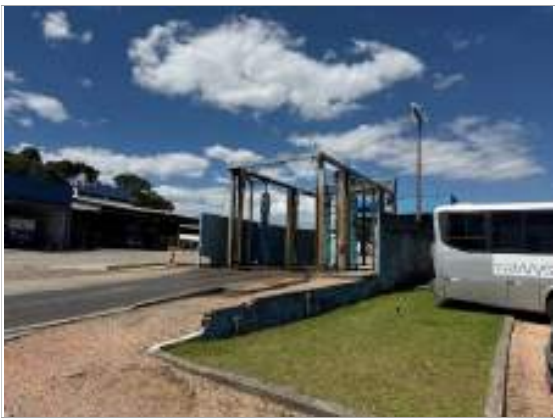
Foto 18 - Vista do lavador
