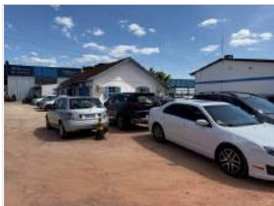
Foto 11 - Vista do Bloco 3 - Administrativo
