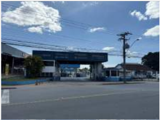
Foto 2 - Fachada do imóvel
