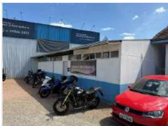
Foto 7 - Vista do Bloco 3 - Administrativo
