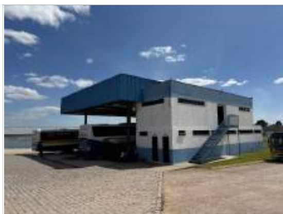
Foto 20 - Vista do Bloco 5 – Pós-lavagem
