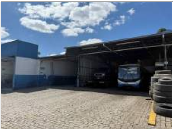
Foto 15 - Vista do Bloco 4 - Manutenção
