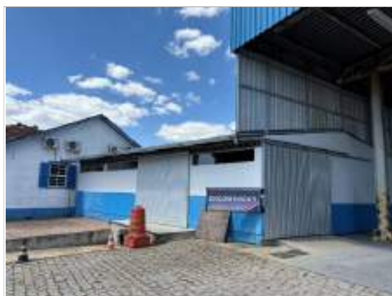
Foto 8 - Vista do Bloco 3 - Administrativo
