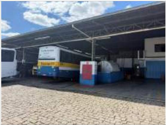
Foto 14 - Vista do Bloco 4 - Manutenção
