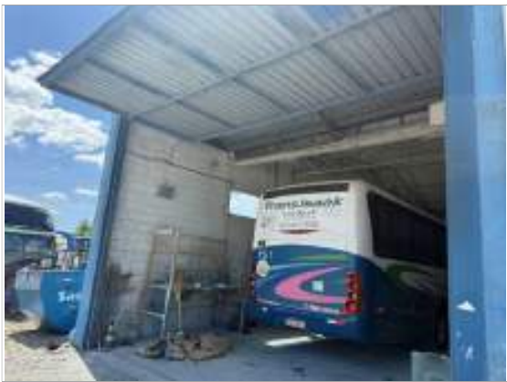
Foto 17 - Vista do Bloco 4 - Manutenção
