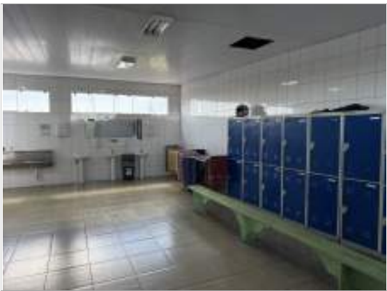
Foto 6 - Vista do interior das edificações
