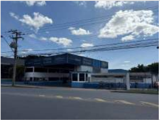
Foto 3 - Fachada do imóvel
