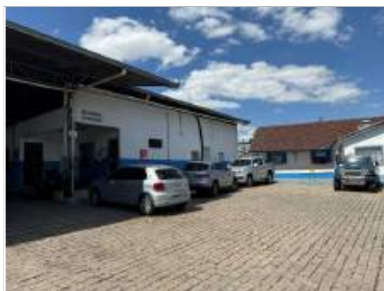
Foto 12 - Vista do Bloco 4 - Manutenção
