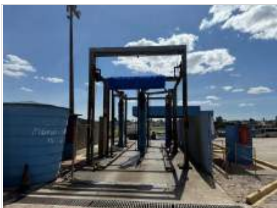
Foto 19 - Vista do lavador
