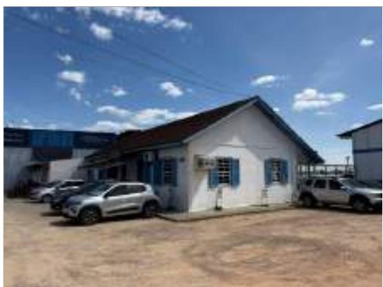
Foto 9 - Vista do Bloco 3 - Administrativo
